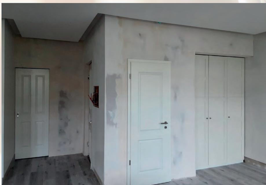
Neben Dachausbau, Wände stellen, Decken abhängen und Fußböden zu legen, lernen Ausbaufacharbeiter und Trockenbaumonteur auch verschiedene Spachteltechniken, damit die Arbeit soweit fertiggestellt wird, dass der Maler starten kann.
