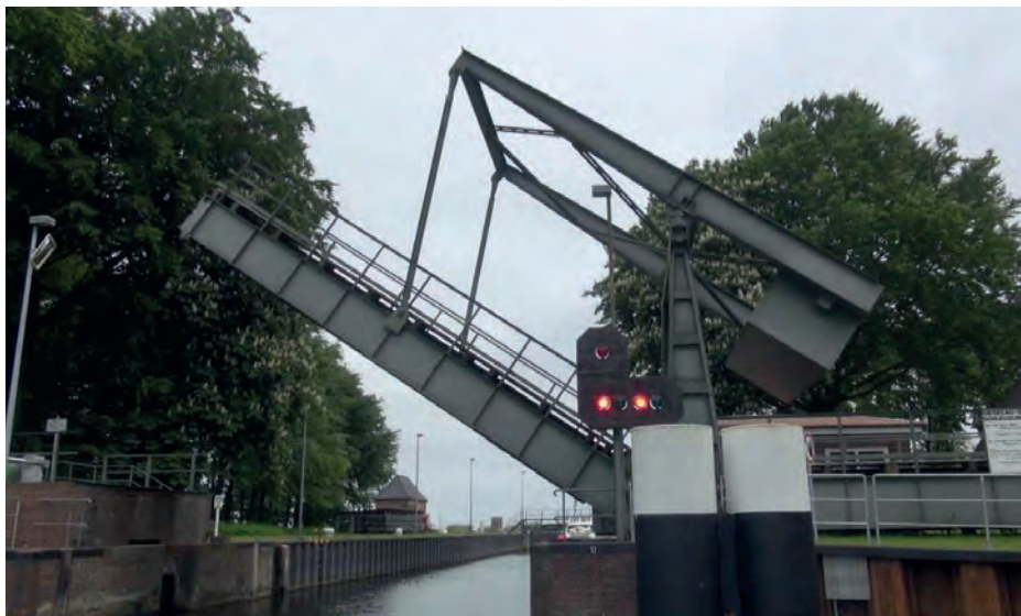
Die Portal-Klappbrücke wurde nach holländischem Vorbild gebaut.
