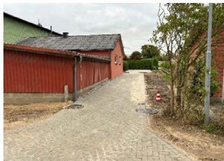
Die Zuwegung für Lieferanten ist schon erneuert und ein Fettabschneider eingebaut.
