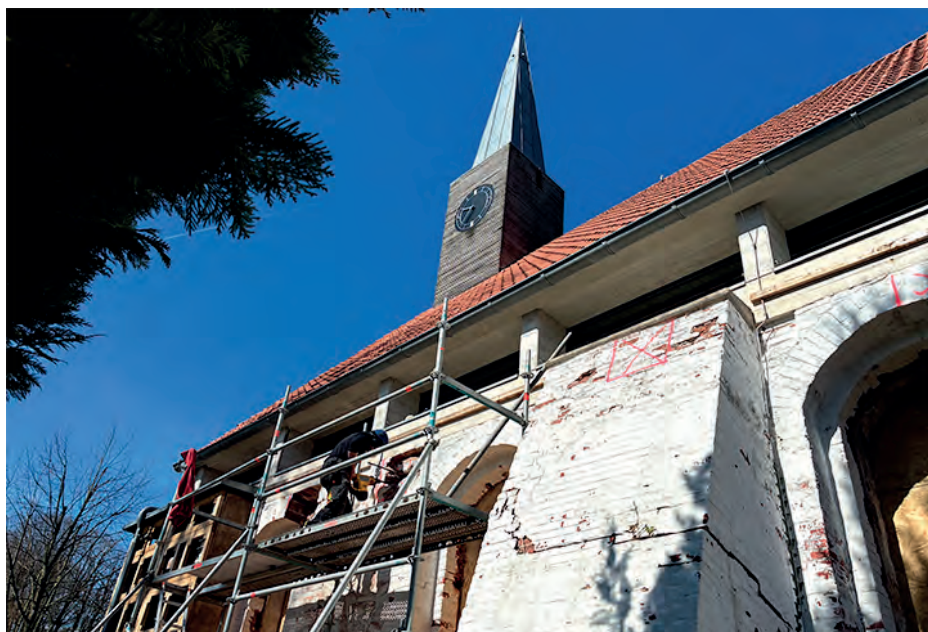
Auf dem Baugerüst: Arbeiter bohren die Steine aus dem Mauerwerk heraus.
