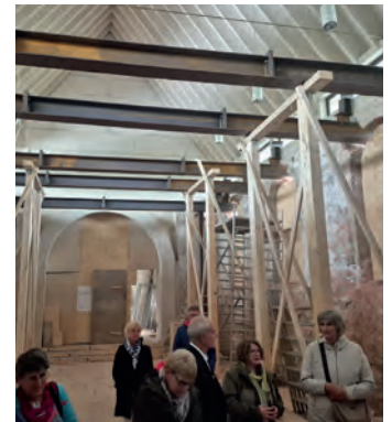
Interessant war die Besichtigung der aktuellen Baustelle der St. Severin-Kirche.
