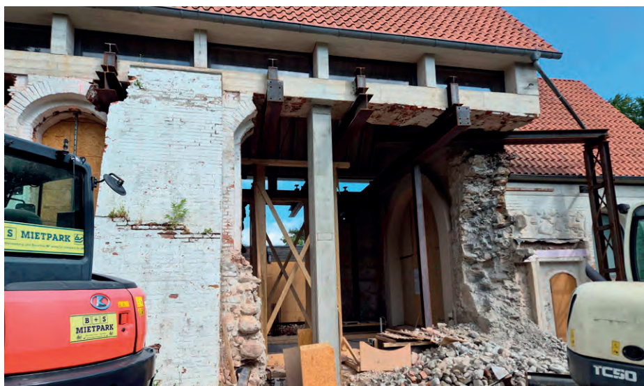
Die Arbeiten sind in vollem Gange.
