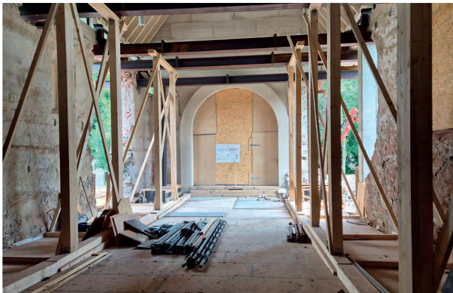
Holzstützen helfen die Stahlträger zu halten, die vorübergehend das Dach tragen.
