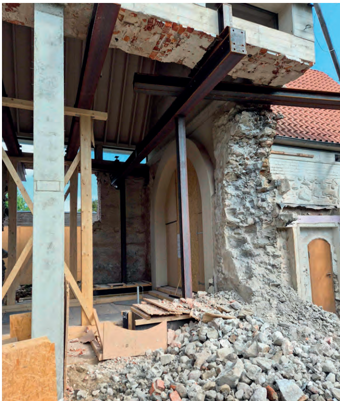
Abschnitt für Abschnitt werden die Steine aus den Kirchenmauern entfernt. Text: Anette Göder, Fotos: Diana Krückmann
