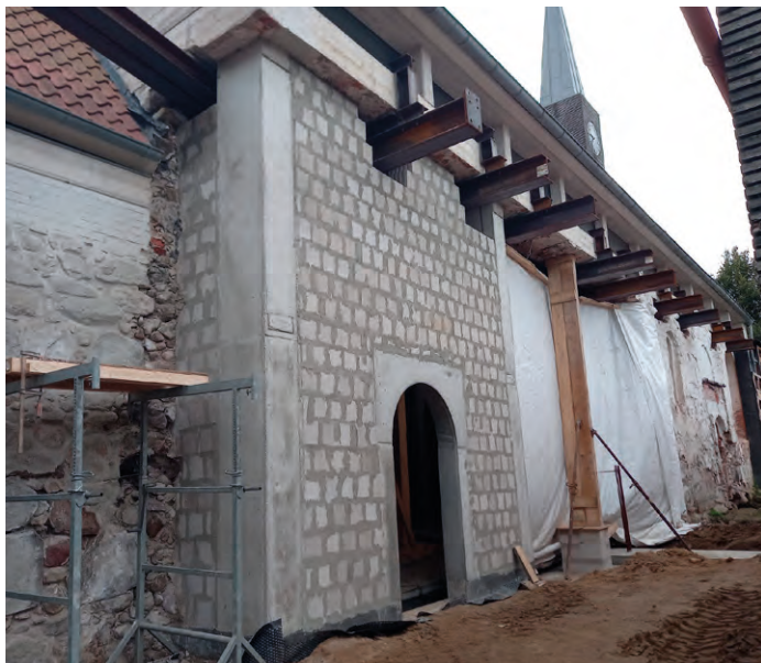
Die erste Mauer ist fertiggestellt. In diesem Bereich stand früher das Taufbecken. Die Seitentür soll einmal für den Brandschutz sowie logistischen Zwecken dienen.
